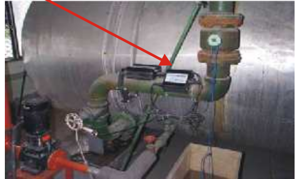
S- HydroFLOW buhar kazanı uygulaması
