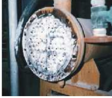
HydroFLOW montajı öncesi Isı E anjörü
