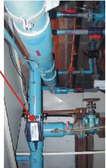
Aqua KLEAR So utma sistemi uygulaması
