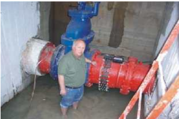
70 cm çaplı boru üzerine HydroFLOW montajı
