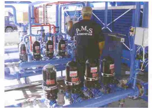
Soğutma suyu filtresi 120 m 3 /saat - 100 mikron
