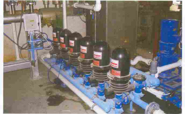
Soğutma suyu filtresi 30 m 3 /saat - 20 mikron
