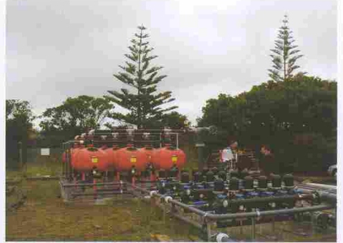
240 m 3 /saat - 100 mikron Balık Çiftliği - Deniz Suyu Filtrasyonu
