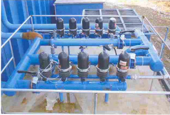
Soğutma suyu filtresi 160 m 3 /saat - 100 mikron
