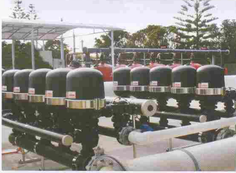
450 m 3 /saat - 55 mikron Balık Çiftliği - Deniz Suyu Filtrasyonu
