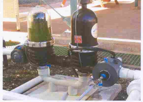
10 m 3 /saat - 55 mikron Deniz Suyu Filtrasyonu
